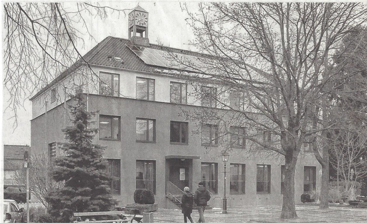
Das Bezirksamt Eilendorf mit der neu gestalteten Fassade.
